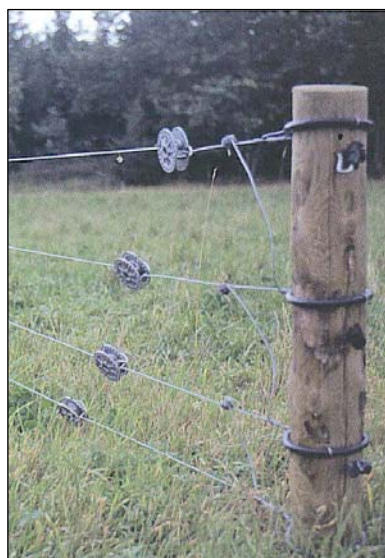
Figur 2. Endestolpe på et strekkjerd. Trådstrammere ses på hver tråd (etter DeLaval).
