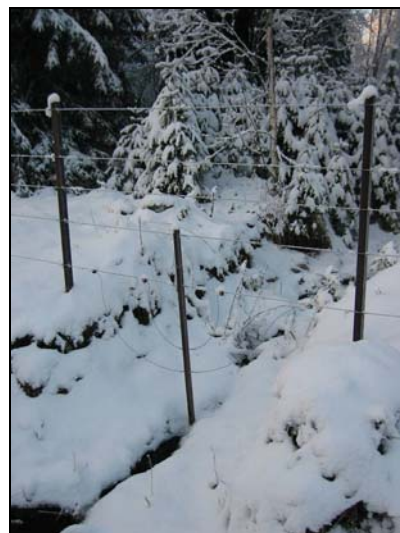
Figur 6. Eksempel på sikring av grøft ved hjelp av supplerende tråder (foto: Inger Hansen).
